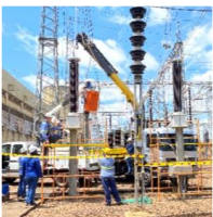
Substituição de equipamentos de alta tensão da SEMD
